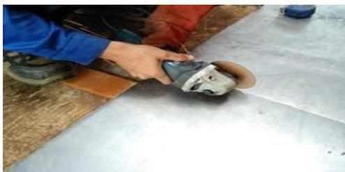
Gambar 12. Pemotongan Atap
