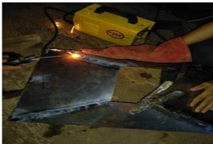
Gambar 10. Penyambungan Bak Penampung
